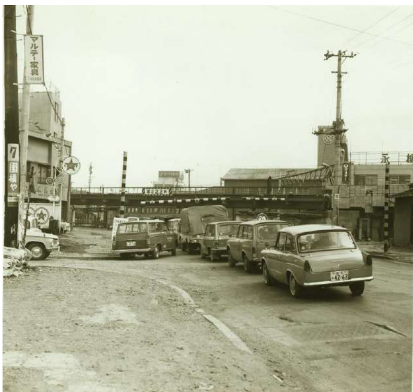
東武高架工事※5
