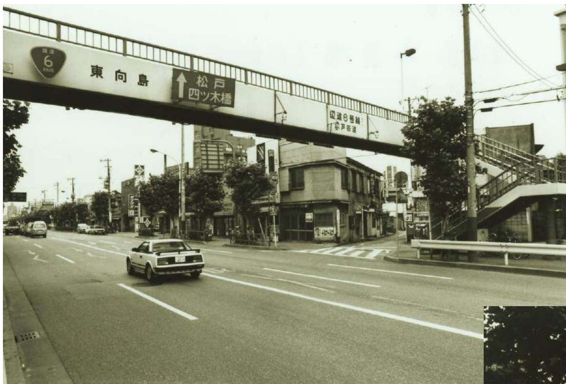
水戸街道 東向島6-1 消防署前歩道橋※17
