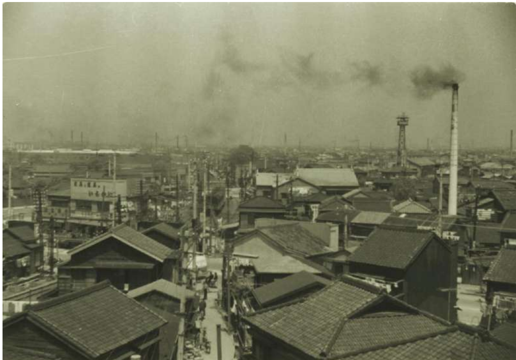
第2庁舎屋上から北方向※1
