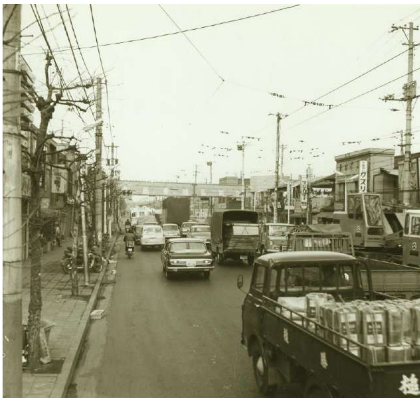
東武高架工事※7
