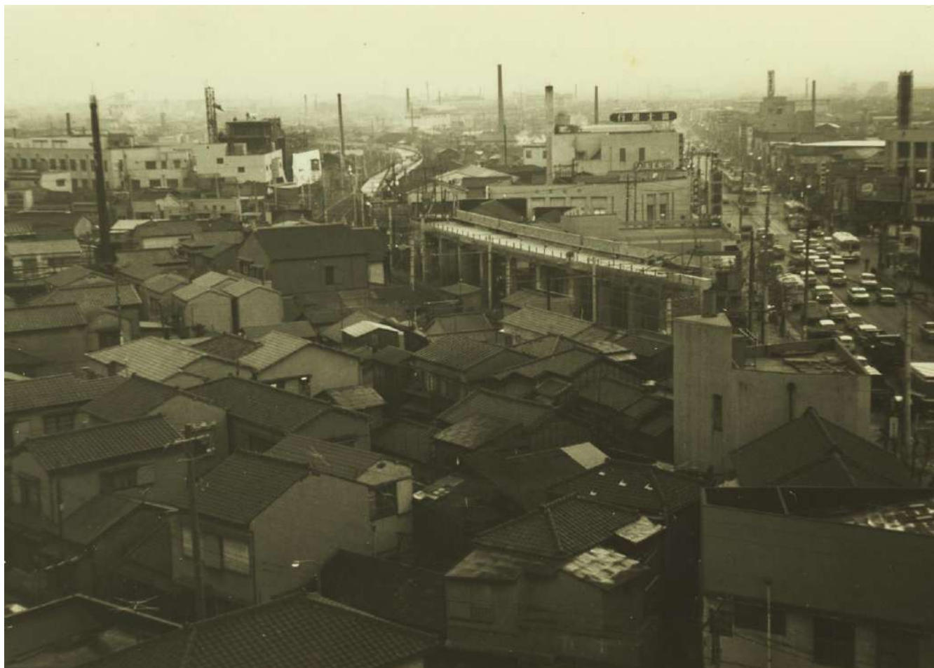
東武高架工事 曳舟～東向島(玉ノ井)※4
