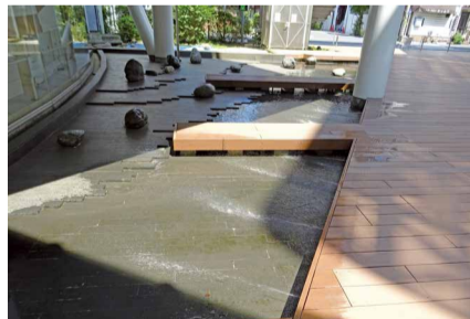
トイレや消防用水、せせらぎに活用(せせらぎの稼働は夏季のみ)
